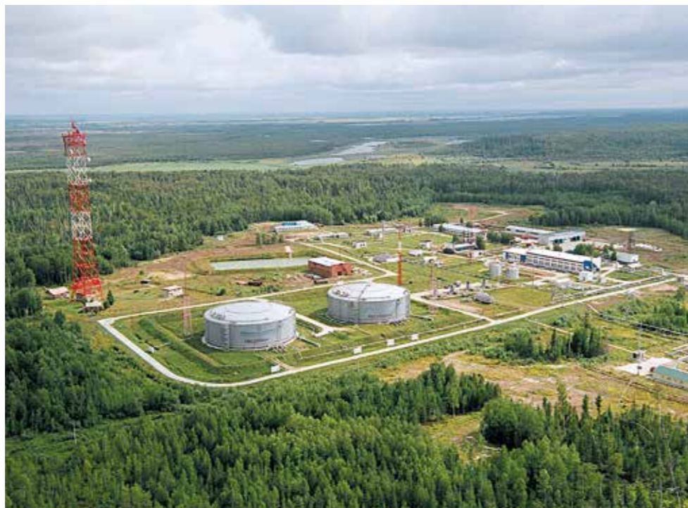
→ Томская область, Александровский район, НПС «Раскино», капитальный ремонт объектов станции, 2000-2010 годы
