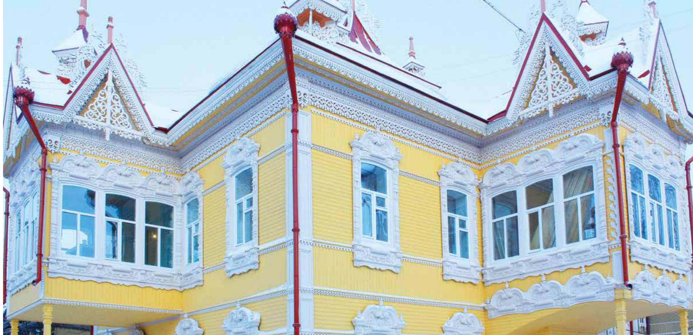
→ Город Томск, ул. Красноармейская, 67а, реконструкция, 2009-2010 годы
